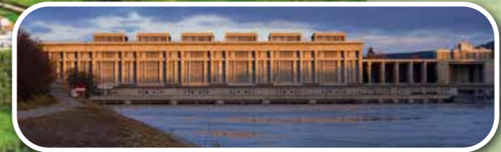
Centrale de Bollène (Vaucluse)
