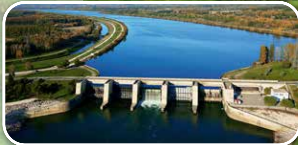
Barrage de Villeneuve-lez-Avignon (Gard)
